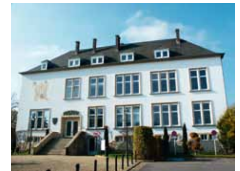
Das 1950 an die Jungenschule angebaute Gemeindehaus L'Administration communale qui a été ajoutée à l'école de garçons en 1950
