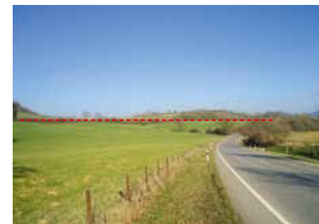
Der Streckenverlauf orientierte sich an den Höhenlinien. Um zu große Steigungen zu vermeiden, wurden zum Teil weite Bögen gefahren, die im Gelände heute noch gut sichtbar sind. Le tracé s'adaptait aux différences de niveau. Afin d'éviter des dénivelés trop importants, le tracé faisait de larges courbes encore bien visibles actuellement sur le terrain.
